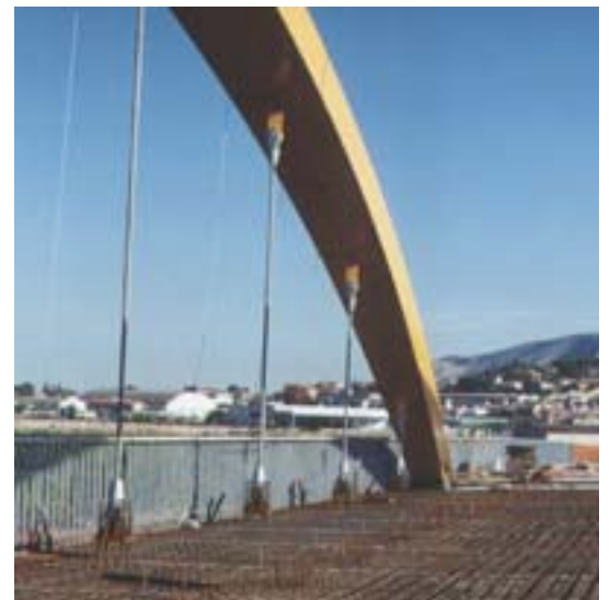
Figura 11. Conexión péndola-tablero. Tesado de péndolas.
