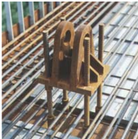
Figura 11. Conexión péndola-tablero. Tesado de péndolas.
